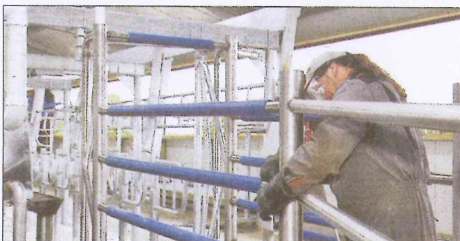
Die Stalleinrichtungen müssen sorgfältig montiert werden.
