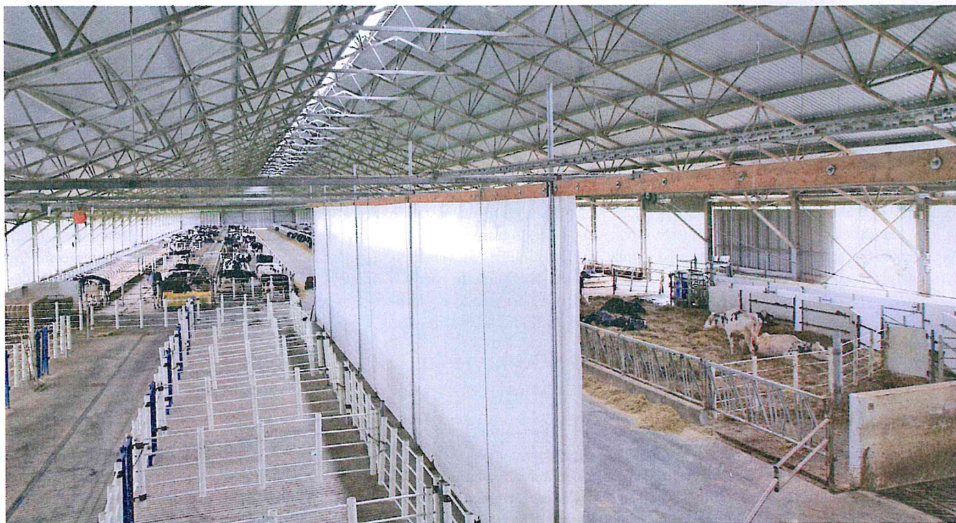
Kühe im Transitbereich kommen im Gut Hohen Luckow (Mecklenburg-Vorpommern) in einem extra für sie gebauten Stall unter. Die Abkalbeboxen (unten links) lassen sich leicht reinigen und desinfizieren. Vor dem Kalben sind die Tiere in Abteilen mit Tiefliegeboxen und danach auf Tiefstreu untergebracht. Fotos: Sabine Rübensaat
